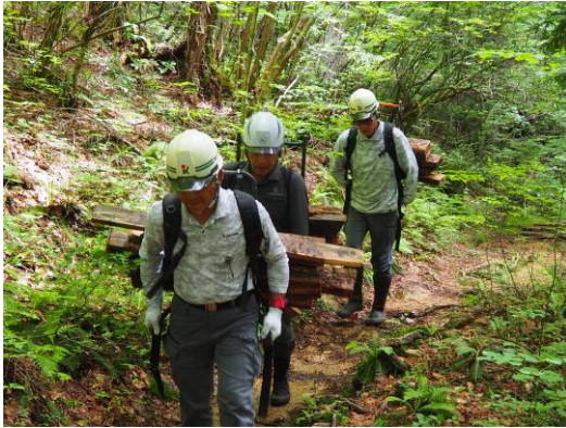
廃材の人力運搬
