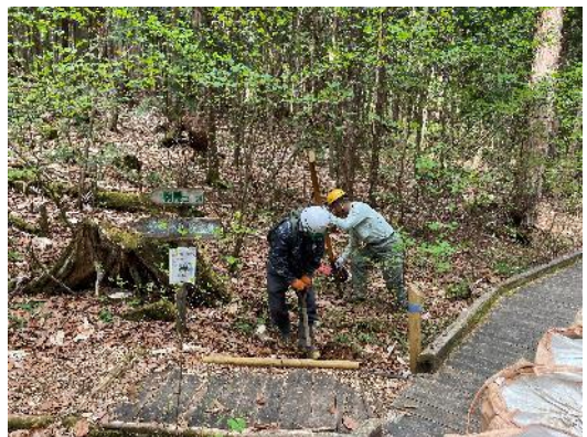
案内板の移設
