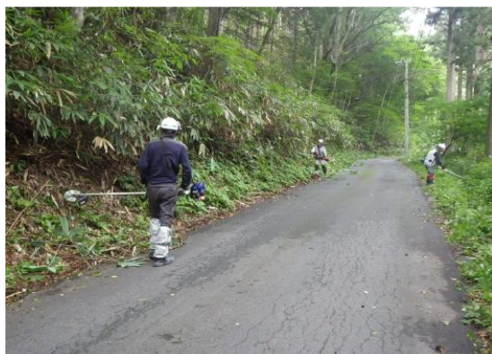
林道沿線の作業の様子
