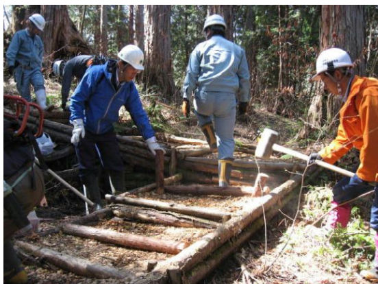
遊歩道に階段設置作業
