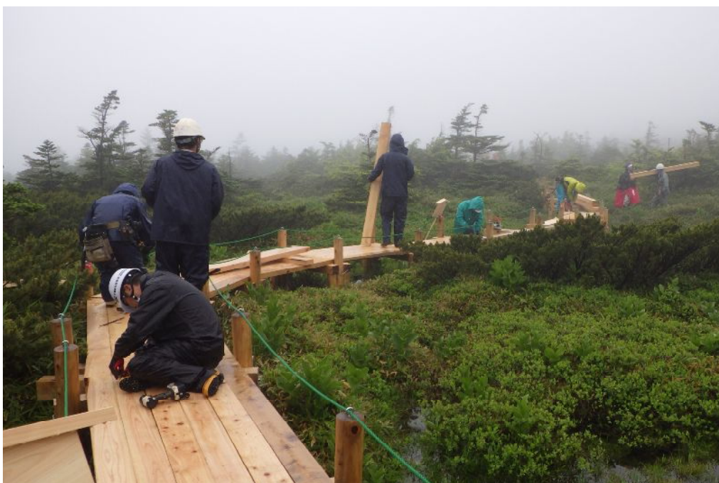
遊歩道の敷板張り作業
