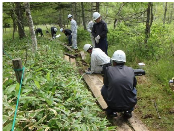
遊歩道（木道）の修繕
