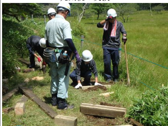
遊歩道（木道）の整備
